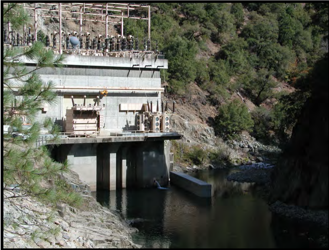
CM-4. Camino Powerhouse
