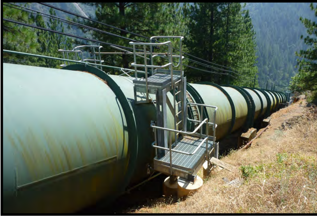
CM-3. Camino Penstock
