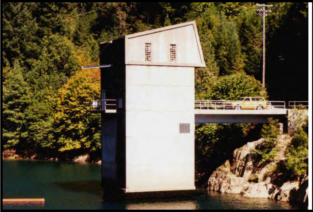
CM-7. Brush Creek Gate House
