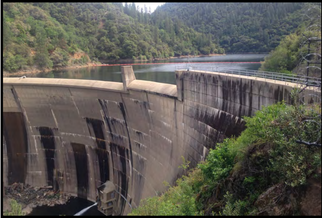
WR-1. Slab Creek Dam
